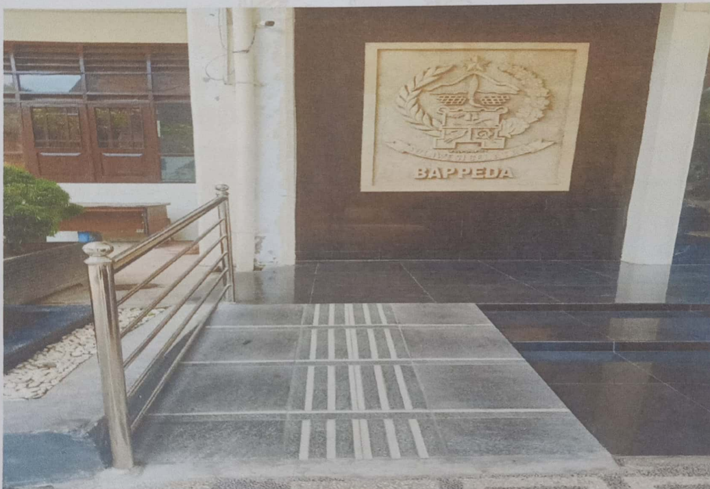
Gambar 9. Tangga Penyandang Disabilitas
